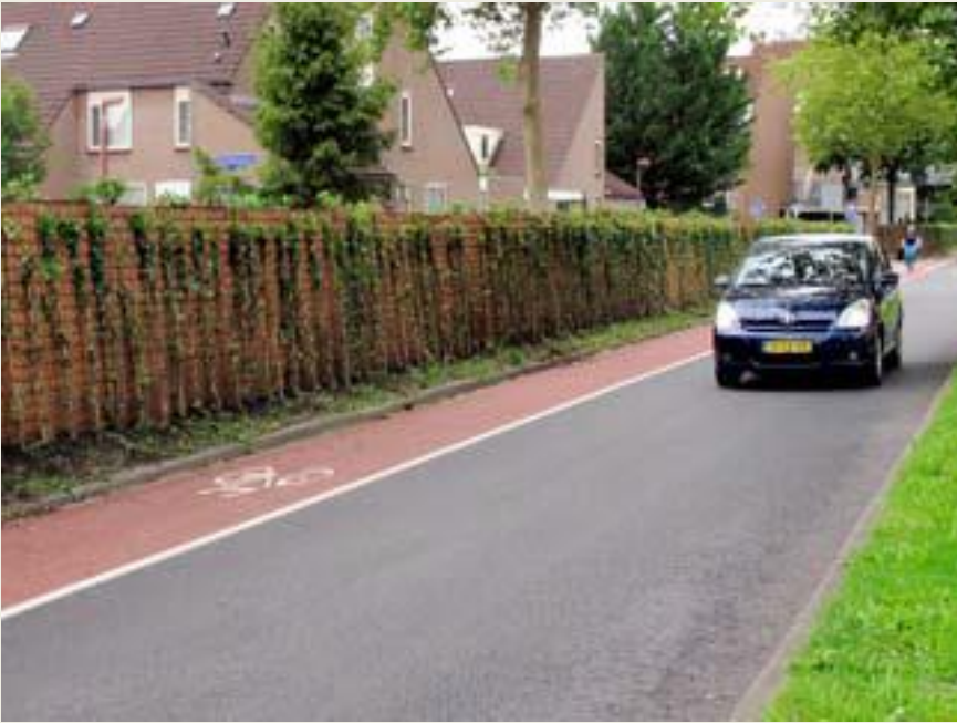
Groen geluidsscherm na plaatsing
